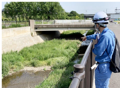
土砂堆積調査(目視点検)
