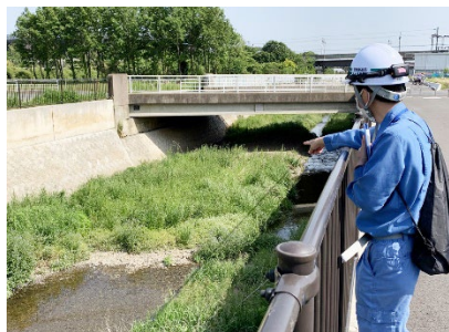
土砂堆積調査(目視点検)
