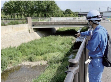
土砂堆積調査(目視点検)
