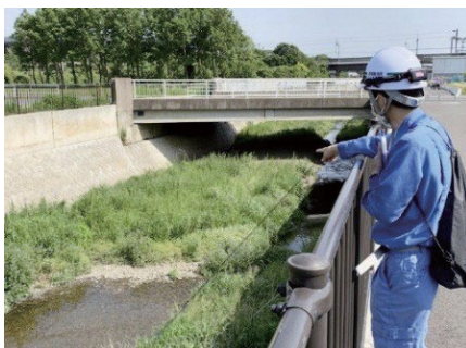
土砂堆積調査（目視点検）
